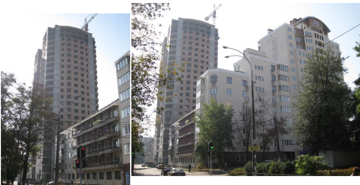
Стан будівництва житлових будинків №№ 1, 2, 4 по вул. М. Кривоноса та Климента на 16.09.2009 р.
