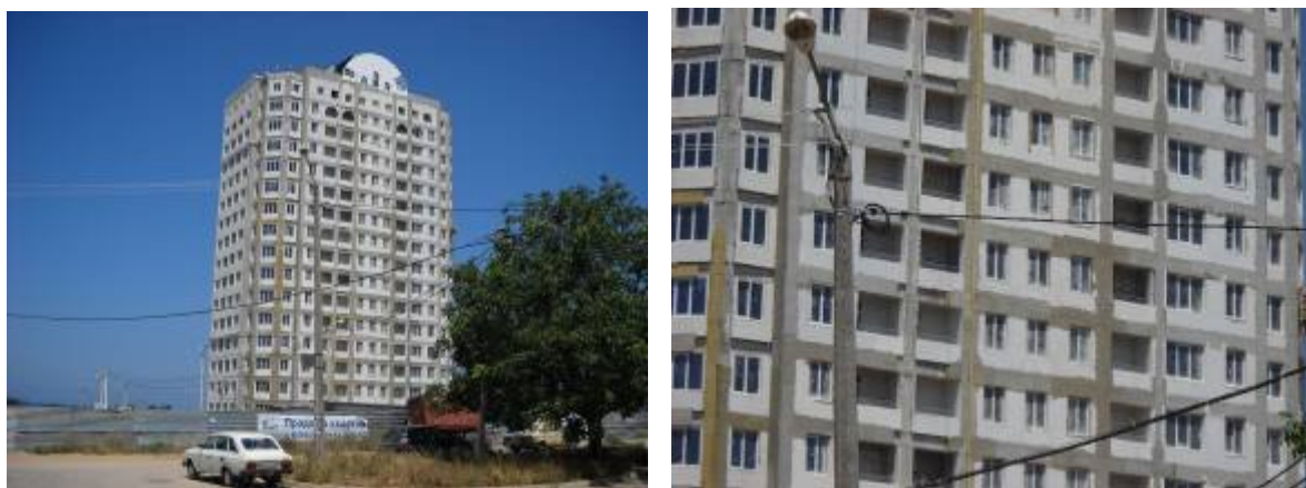
Стан виконання будівельних робіт по корпусу 6 в мікрорайоні «Омега-2а» у м. Севастополі станом на початок липня 2010 року
