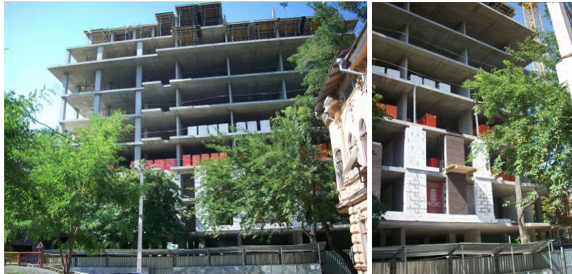
Будівництво житлового будинку по вул. Відрадній, 13 станом на початок вересня 2009 року
