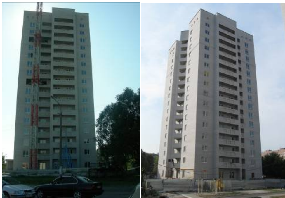
Об'єкт будівництва в районі вулиць Космічної та Мандриківської, м. Дніпропетровськ (друга черги) станом: (зліва-направо): на кінець травня 2009 року та на вересень 2009 року
