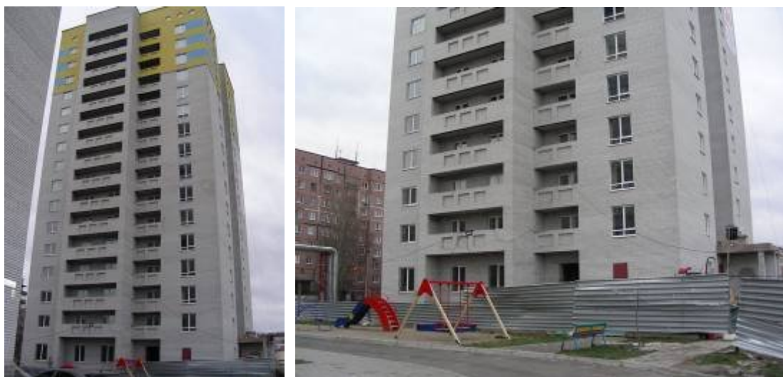
Об'єкт будівництва в районі вулиць Космічної та Мандриківської, м. Дніпропетровськ (друга черги) станом на грудень 2009 року
