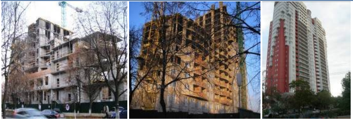
Хід робіт на об'єкті будівництва по вул. П. Запорожця, 26-А у м. Києві станом на початок листопада 2007 року, початок лютого 2008 року та вересень 2009 року (зліва направо)
