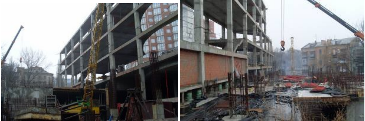
Рисунок 2.2. Стан реалізації інвестиційно-будівельного проекту у кварталі, що обмежений пр. Пушкіна – пров. Ушинського – вул. Щорса – вул. Херсонською, м. Дніпропетровськ, станом на початок лютого 2009 р.
