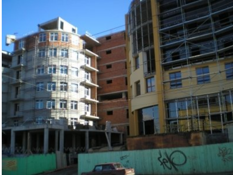
Хід будівництва групи багатоквартирних житлових будинків по вул. Червоноармійській, 43 В у м. Чернівцях станом на початок 2009 року
