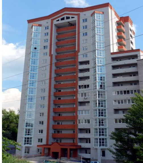
Житловий комплекс по вул. Тополиній, 7, м. Дніпропетровськ
