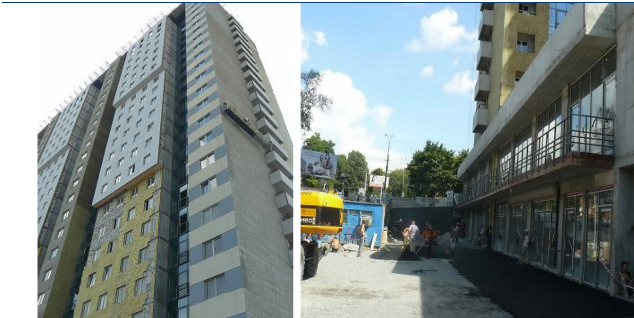
Хід робіт на об'єкті будівництва по вул. Ульянова, в районі буд. 17 А у м. Дніпропетровську станом на 10.08.2009 р.
