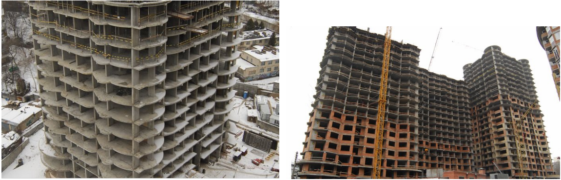
Рисунок 1.1. Будівельні роботи на об'єкті будівництва житлового комплексу по вул. Механізаторів, 2 (ж/к «Ізумрудний») у Солом'янському районі м. Києва станом на січень 2009 р.
