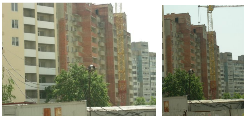
Рисунок 2. Стан будівельної готовності житлового будинку № 18 у мікрорайоні III-4-2 Котовського у м. Одесі станом на червень 2010 р.
