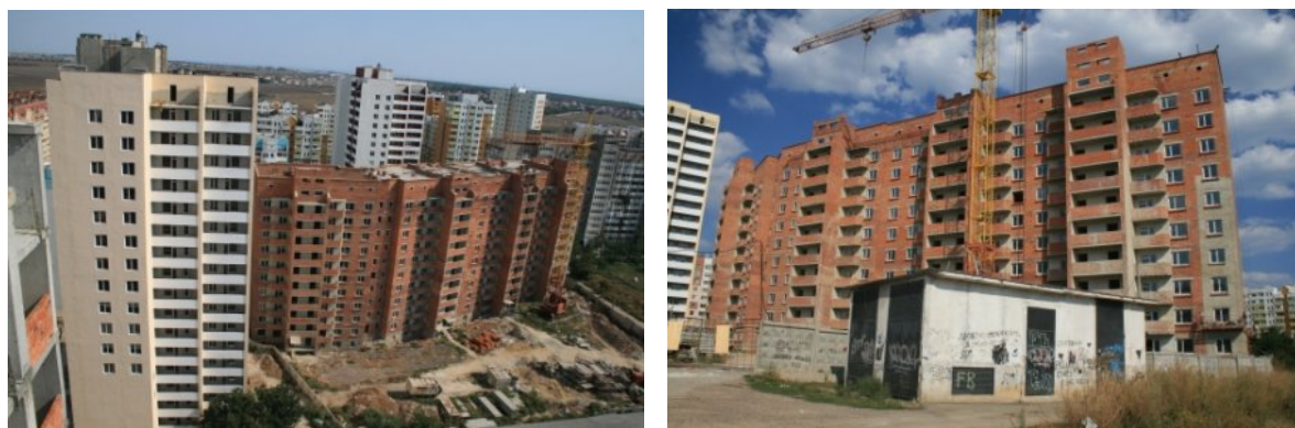
Рисунок 1. Стан будівельної готовності житлового будинку № 18 у мікрорайоні III-4-2 Котовського у м. Одесі станом на кінець 2009 р.
