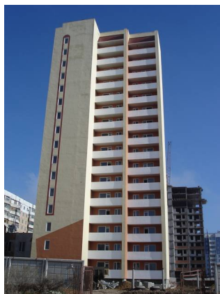
Рисунок 5. Житловий будинок № 28 у мікрорайоні III-4-2 Котовського у м. Одесі
