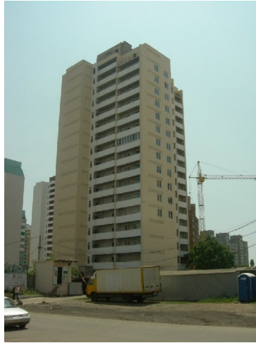
Рисунок 7. Житловий будинок № 29 у мікрорайоні III-4-2 Котовського у м. Одесі
