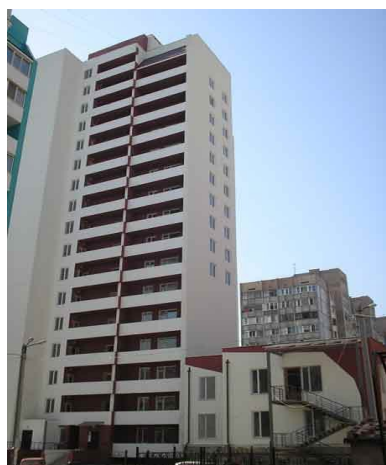
Рисунок 3. Житловий будинок № 30 у мікрорайоні III-4-2 Котовського у м. Одесі
