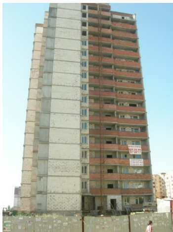
Рисунок 4. Стан будівельної готовності житлового будинку № 27 у мікрорайоні III-4-2 Котовського у м. Одесі станом на 27.08.2010 р.
