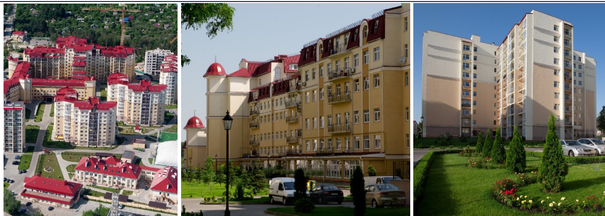
Рисунок Ошибка! Текст указанного стиля в документе отсутствует..1. Житловий комплекс «Чайка» по вул. Лобановського, 1 у с. Чайці Києво-Святошинського району Київської області (I черга)
