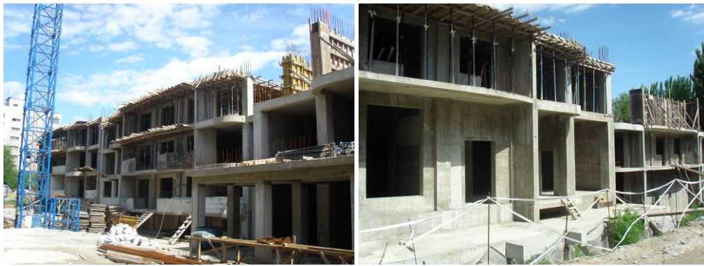
Рисунок 2.4. Будівельні роботи по вул. Грязнова станом на середину травня 2009 року
