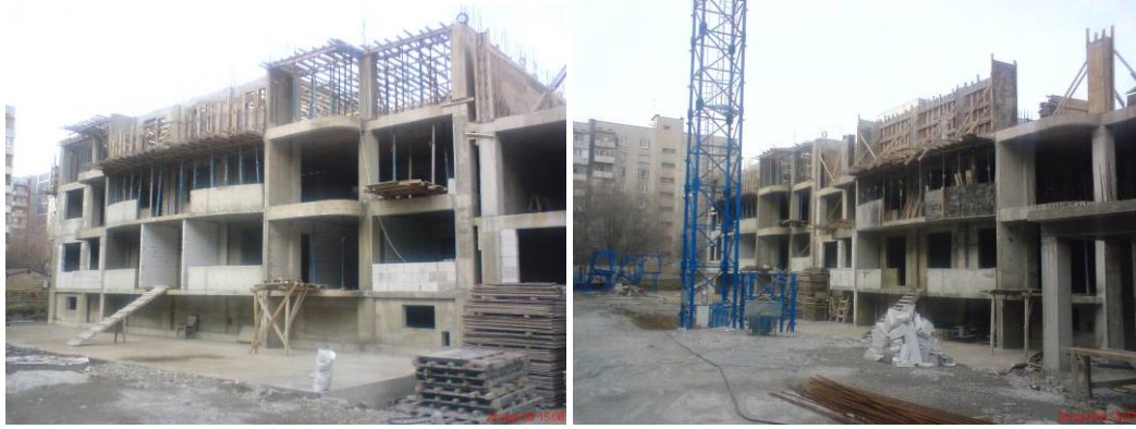
Рисунок 2.3. Будівельні роботи по вул. Грязнова станом на середину лютого 2009 року
