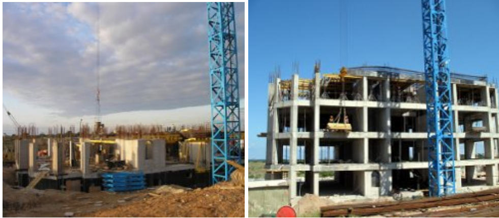
Рисунок 1.2. Стан виконання будівельних робіт по корпусу 6 в мікрорайоні «Омега-2а» у м. Севастополі станом на листопад 2007 року та на кінець травня 2008 року
