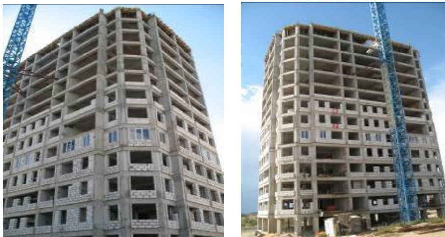
Рисунок 1.4. Стан виконання будівельних робіт по корпусу 6 в мікрорайоні «Омега-2а» у м. Севастополі станом на травень 2009 року
