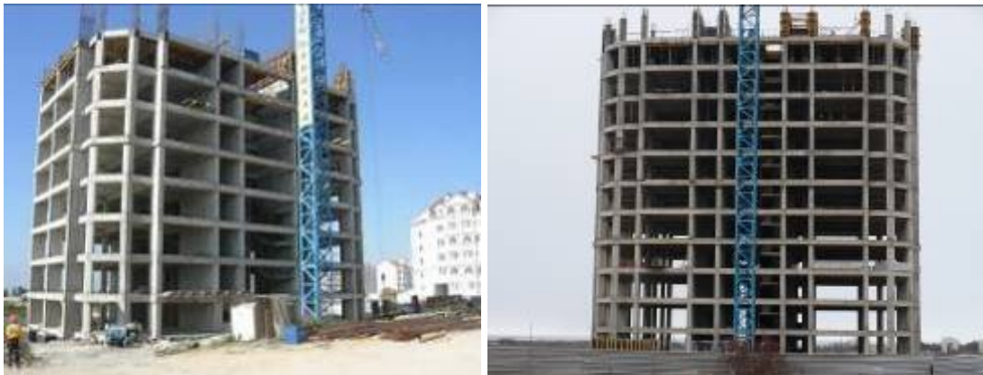
Рисунок 1.3. Стан виконання будівельних робіт по корпусу 6 в мікрорайоні «Омега-2а» у м. Севастополі станом на 05.09.2008 р. та на початок листопада 2008 року та станом на лютий 2009 року
