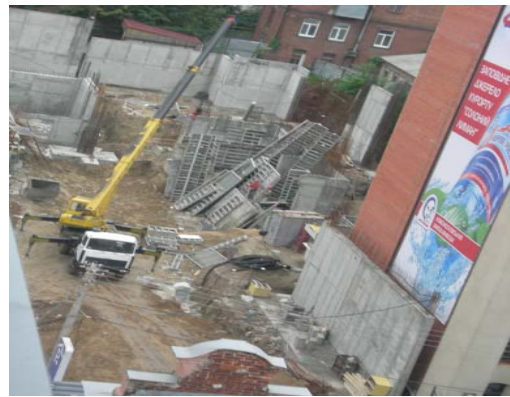
Рисунок 3.1. Будівництво багатофункціонального комплексу по вул. Шевченка, 53, станом на 21.09.2007 р.
