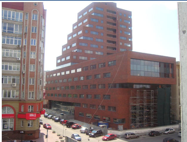
Хід будівництва багатофункціонального комплексу по вул. Шевченка, 53, станом на кінець 2010 року
