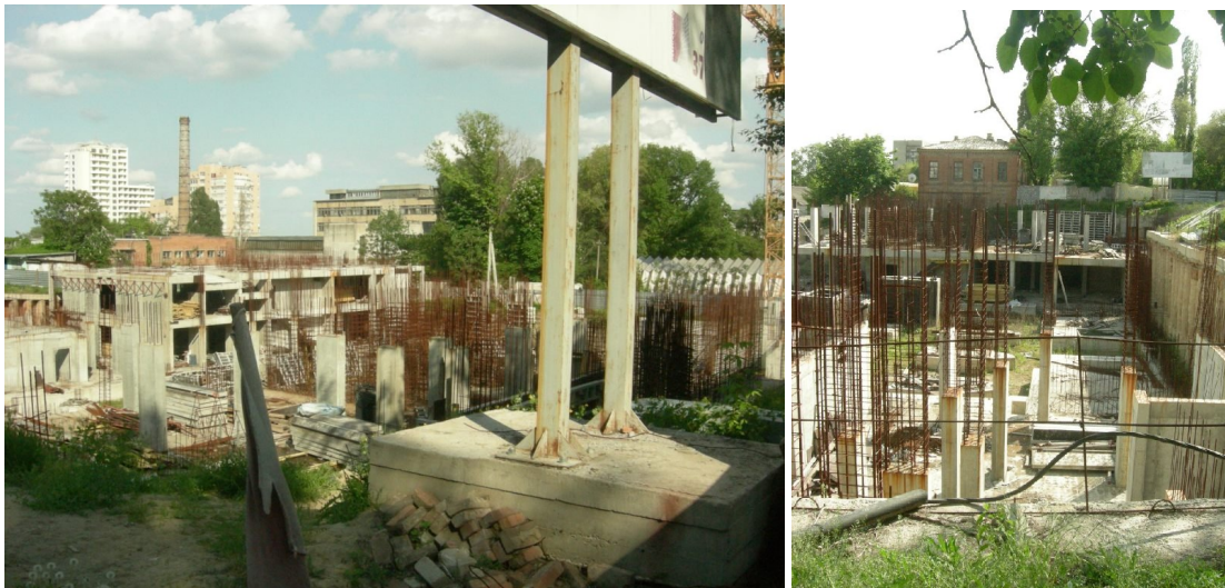
Рисунок 2. Будівництво житлового будинку по вул. Фурманова, 11 у м. Дніпропетровськ, 2010 р.
