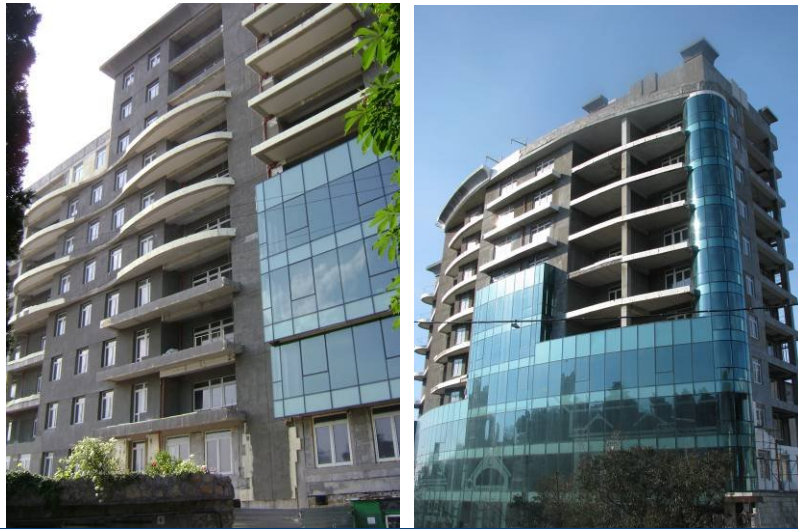
Хід робіт на об'єкті будівництва житлового комплексу «Адміралтейський» класу «люкс» по вул. Руданського, буд. 8 Б станом на кінець серпня 2009 року
