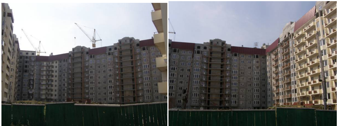
Рисунок 7. Будівництво житлового будинку у с. Чайці Київської області по вул. Коцюбинського, 9 (будівельний № 36) на 28.08.2009 р.
