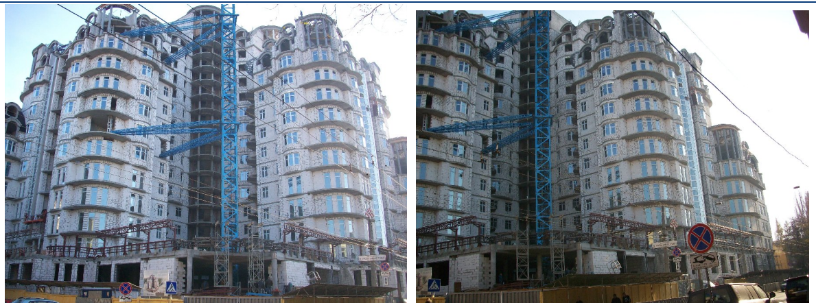
Будівельні роботи на об'єкті будівництва офісно-житлового комплексу по вул. Канатній, 27 станом на кінець листопада 2009 р.
