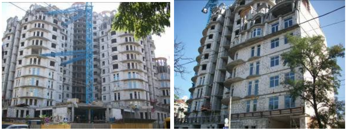
Будівельні роботи на об'єкті будівництва офісно-житлового комплексу по вул. Канатній, 27 станом на початок вересня 2009 р.
