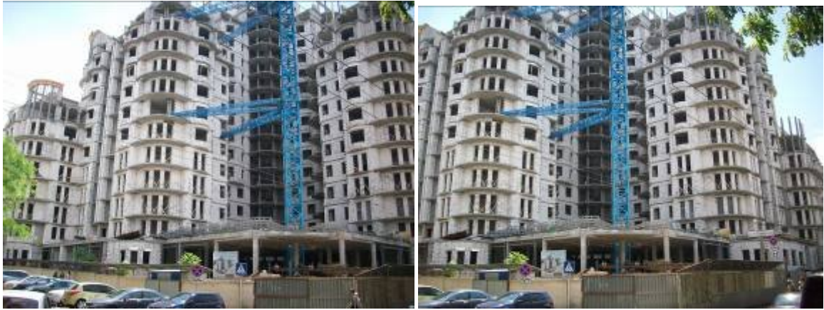
Будівельні роботи на об'єкті будівництва офісно-житлового комплексу по вул. Канатній, 27 станом на кінець травня 2009 р.
