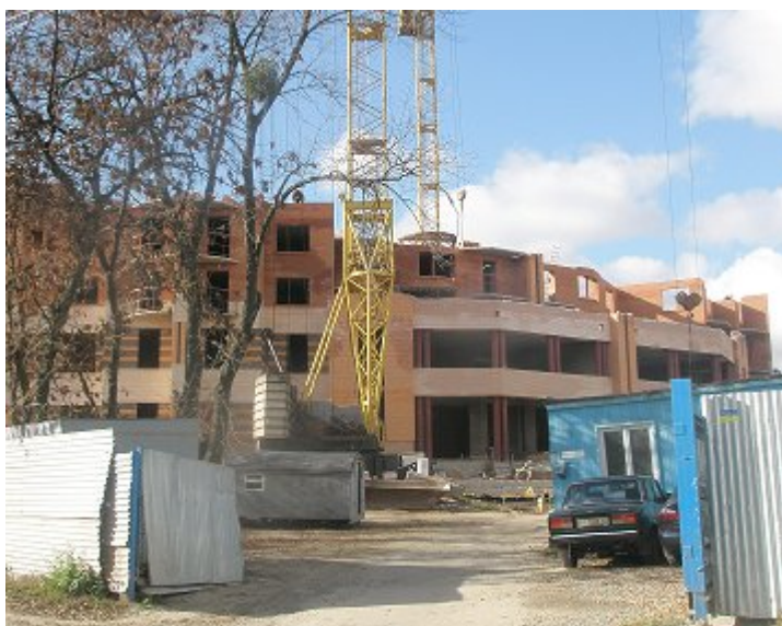
Житловий будинок по вул. Леніна, 74 у м. Полтаві, станом на 02.11.2009 р.
