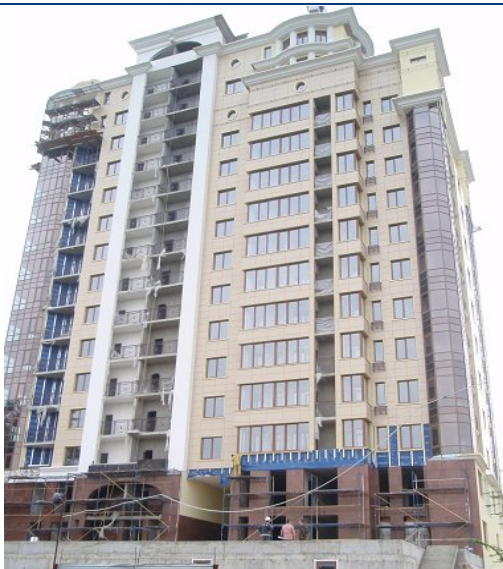
Стан будівництва житлового комплексу по вул. Фронтівій, 3 у м. Харкові станом на кінець вересня 2011 року
