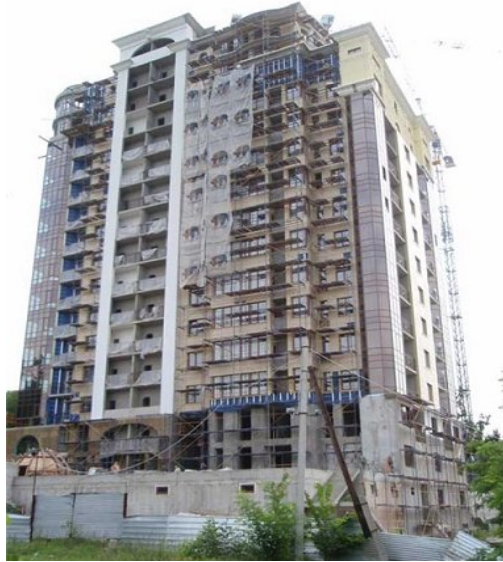
Стан будівництва житлового комплексу по вул. Фронтівій, 3 у м. Харкові станом на початок серпня 2011 року
