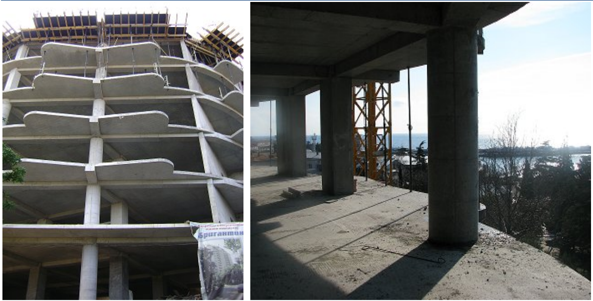
Будівництво багатоповерхового житлового будинку по вул. К. Маркса, 18а у м. Ялті станом на 04.06.2009 р
