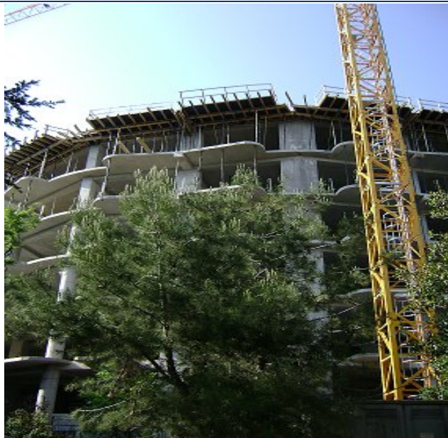
Будівництво багатоповерхового житлового будинку по вул. К. Маркса, 18а у м. Ялті станом на 21.08.2009 р.
