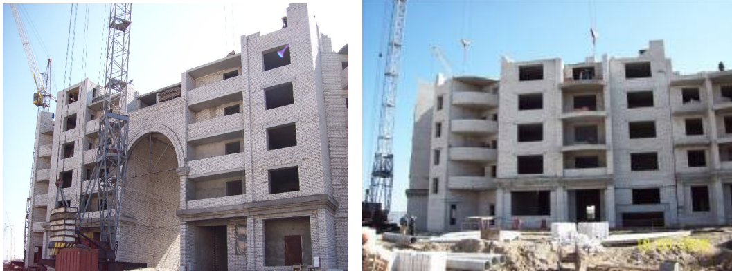
Хід будівництва мікрорайону «Ліски-2» у м. Миколаєві станом на 18.03. 2008 р. (ж/б №№ 10 та 11)
