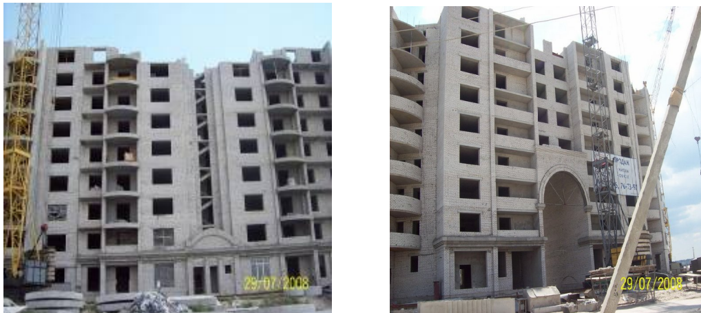
Хід будівництва мікрорайону «Ліски-2» у м. Миколаєві станом на кінець липня 2008 року (ж/б №№ 10 та 11)
