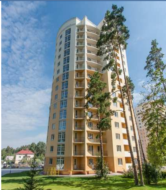
Будинок №8 (II черга) житлового комплексу по вул. Лобановського, 1 у с. Чайці Києво-Святошинського району Київської області станом на кінець серпня 2013 року
