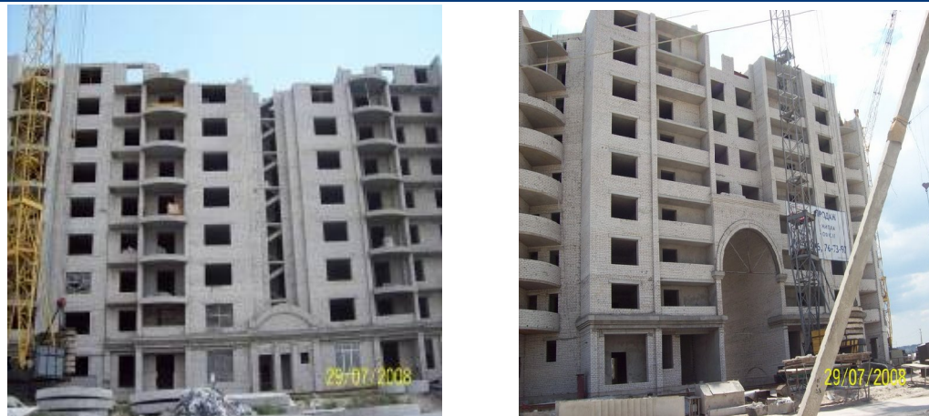
Рисунок 2. Хід будівництва мікрорайону «Ліски-2» у м. Миколаєві станом на кінець липня 2008 року (ж/б №№ 10 та 11)
