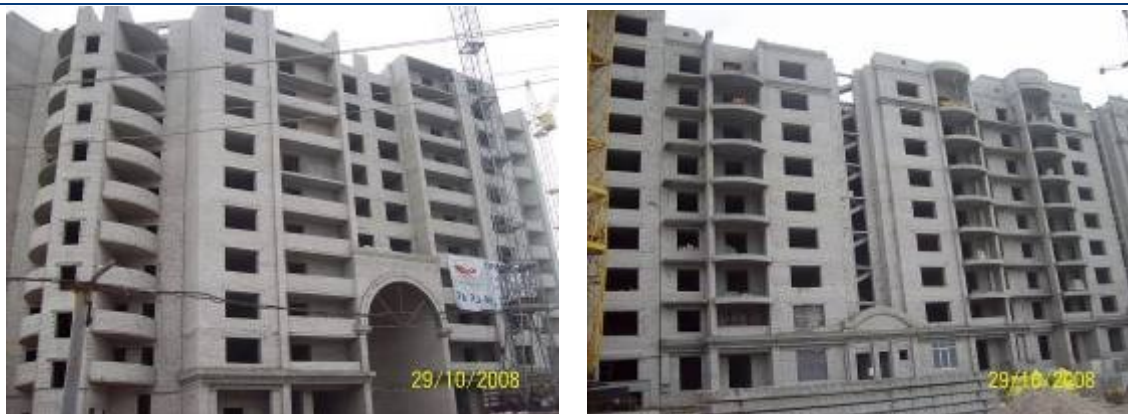
Рисунок 3. Хід будівництва мікрорайону «Ліски-2» у м. Миколаєві станом на кінець жовтня 2008 року (ж/б №№ 10 та 11)
