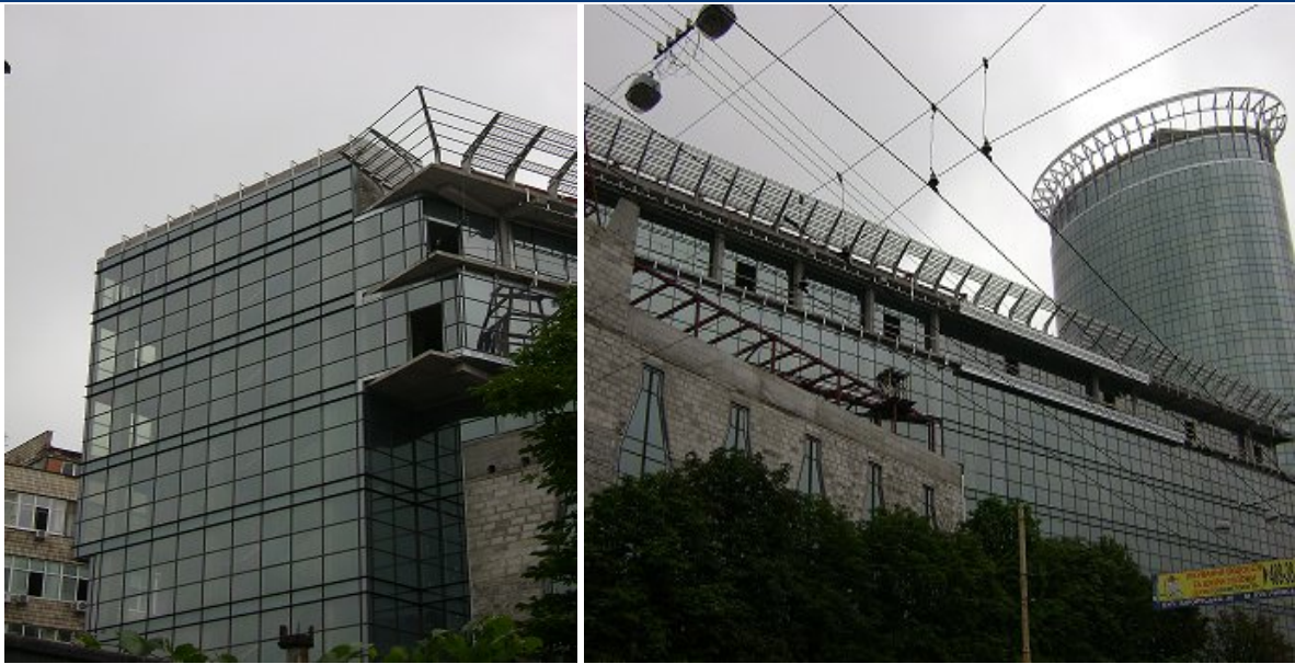
Хід робіт на об'єкті будівництва по вул. Мельникова, 2/10, станом на 24.06.2010 р.
