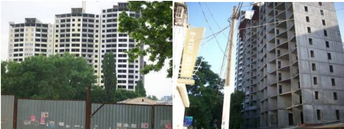
Будівництво житлового комплексу вул. Арміїській, 11 станом на 29.05.2009 р. та станом на 08.09.2009 р.
