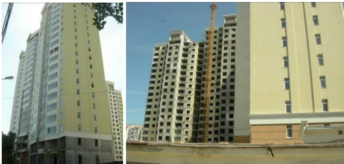
Будівництво житлового комплексу вул. Арміїській, 11 станом на кінець серпня 2010 р.
