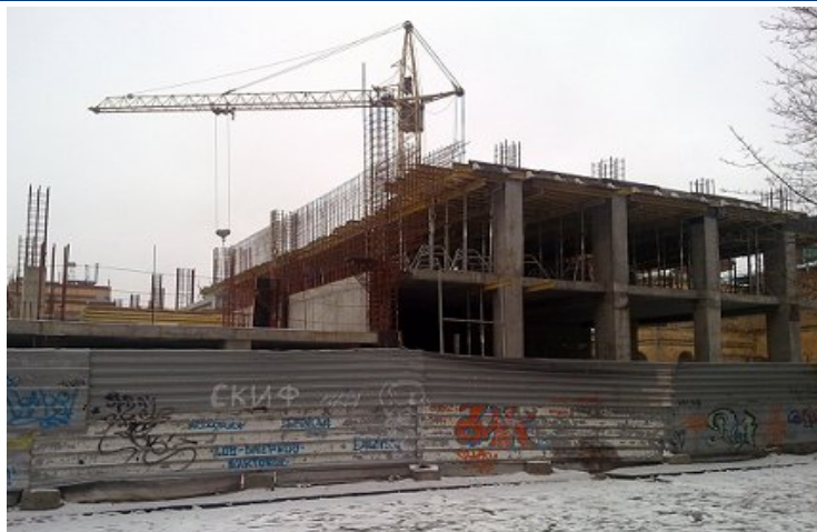
Будівництво багатофункціонального комплексу по вул. Виконкомівській, 1 станом на 03.12.2010 р.
