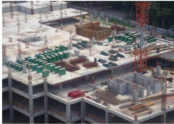
Будівництво багатофункціонального комплексу по вул. Виконкомівській, 1 станом на початок серпня 2010 року
