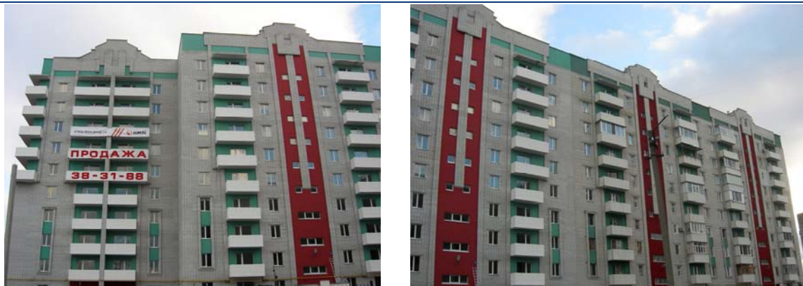
Рисунок 2.5. Стан об'єкта будівництва по вул. Сумгайтській, 19/1 у м. Черкасах на 29.01.2008 р.
