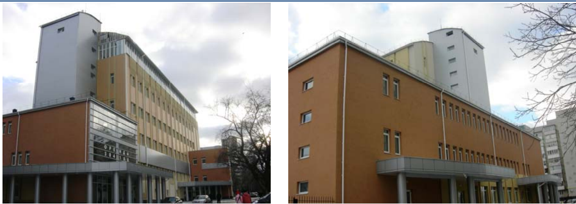
Рисунок 2.6. Стан об'єкта будівництва по вул. Паризької Комуни, 7 у м. Черкасах на 29.01.2008 р.
