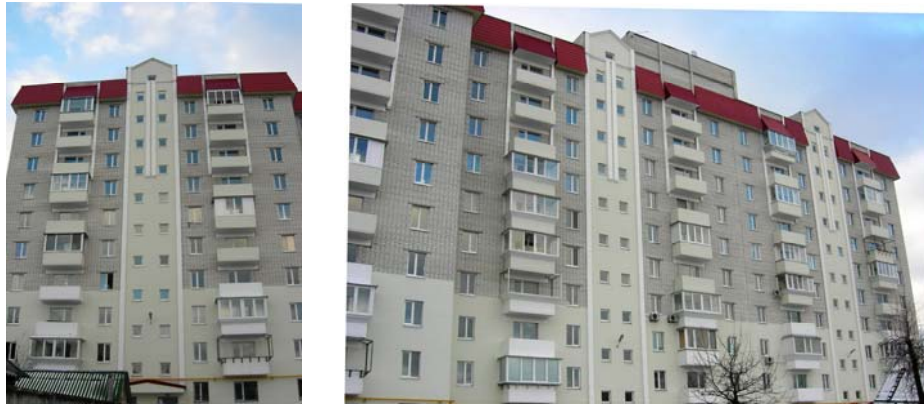
Рисунок 2.4. Стан об'єкта будівництва по вул. Червоноармійській, 157 у м. Черкасах на 29.01.2008 р.
