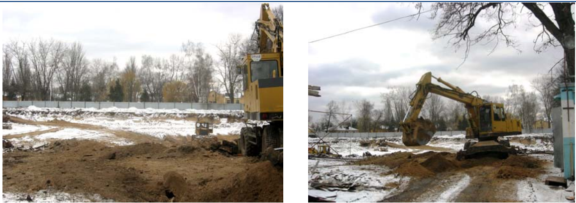
Рисунок 2.3. Хід робіт на об'єкті будівництва по вул. Б. Вишневецького, 70 (буд. номер №78) у м. Черкасах станом на 29.01.2008 р.
