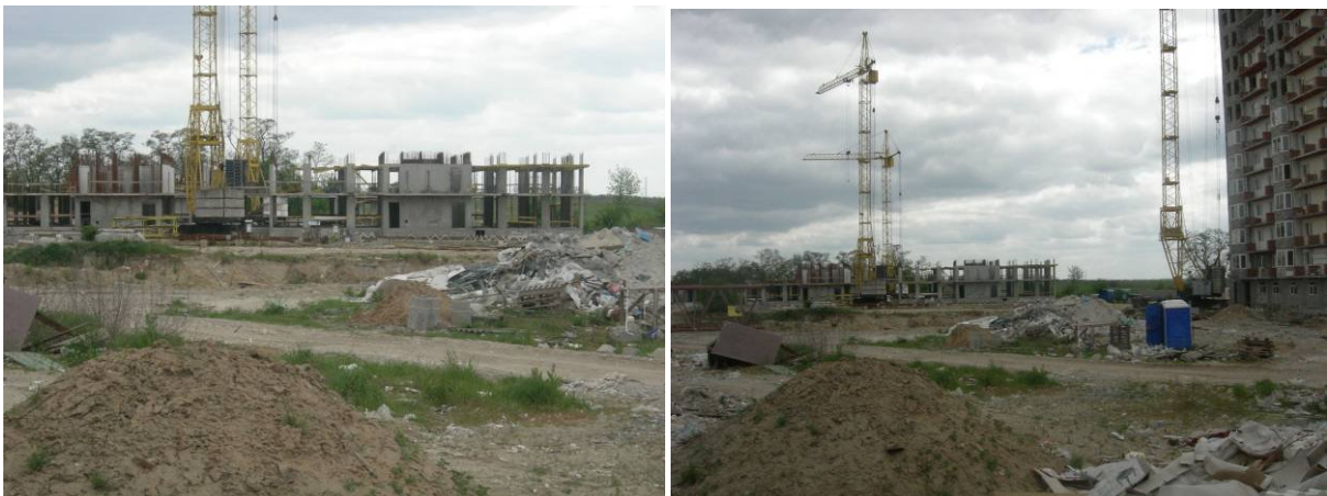
Стан будівництва житлових будинків у с. Чайці по вул. Коцюбинського, 29, 30 Київської області на 18.05.2009 р.
