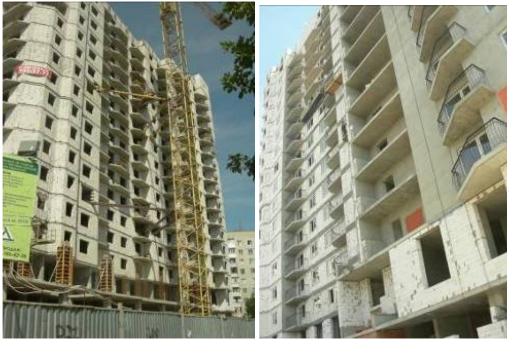
Хід робіт на об'єкті будівництва по вул. Малиновського (на розі вул. Заводської та пров. Союзного) в м. Одесі станом на кінець серпня 2010 р.
