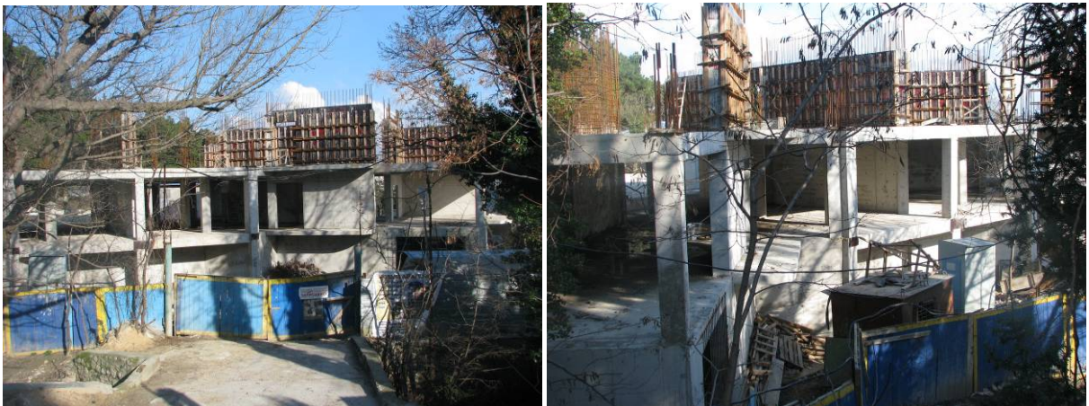
Хід будівництва рекреаційного комплексу по вул. Луговського в смт. Сімеїз станом на 20.02.2009 р.
