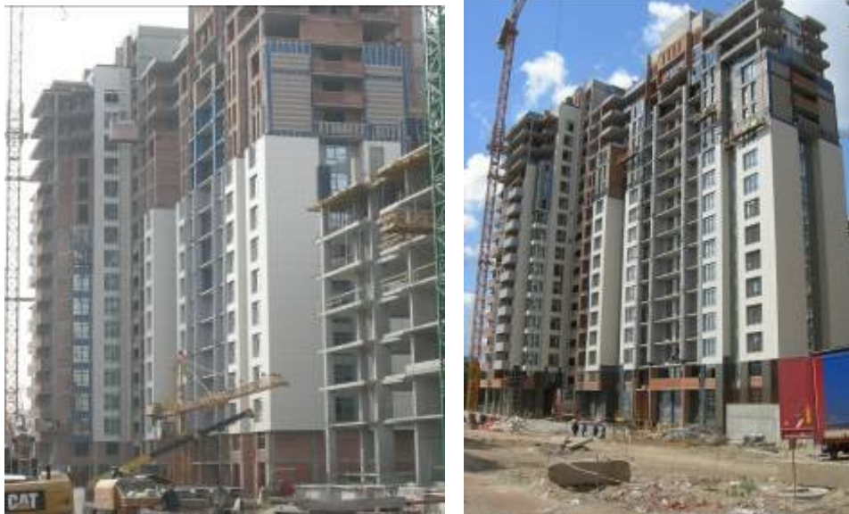
Рисунок 1.5. Хід робіт з будівництва ж/б 5 по вул. Професора Підвисоцького у Печерському районі м. Києва станом (зліва-направо): на 12.03.2009 р. та на 18.06.2009 р.
