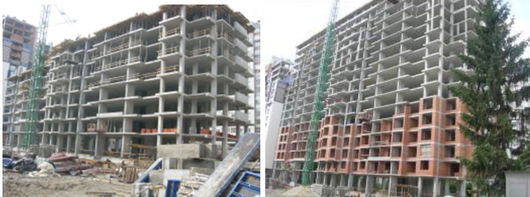
Рисунок 1.4. Хід робіт з будівництва ж/б 4 по вул. Професора Підвисоцького у Печерському районі м. Києва станом (зліва-направо): на 12.03.2009 р. та на 18.06.2009 р.
