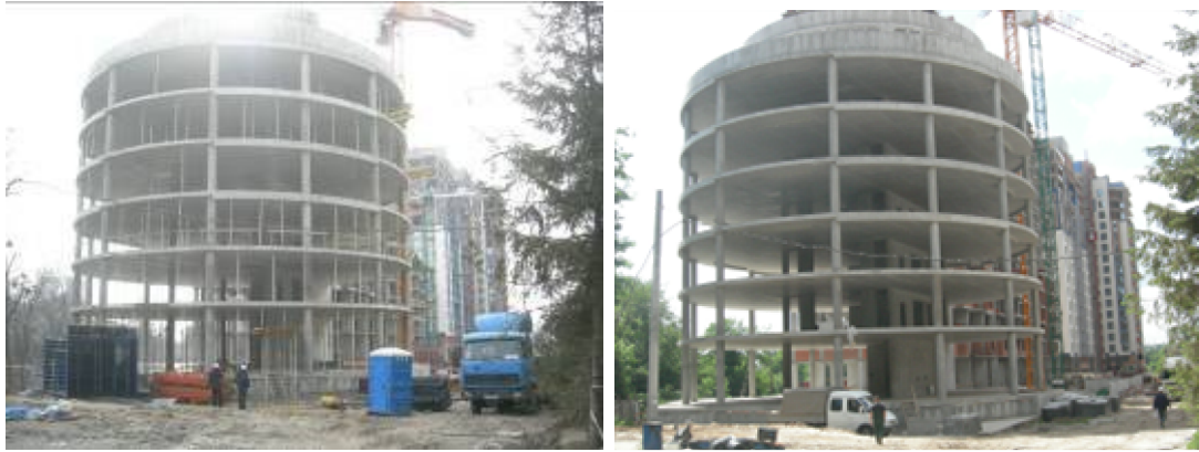
Рисунок 1.1. Хід робіт з будівництва ж/б 1 по вул. Професора Підвисоцького у Печерському районі м. Києва станом (зліва-направо): на 12.03.2009 р. та на 18.06.2009 р.
