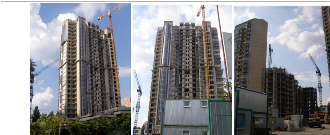
Будівництво житлово-офісного комплексу з вбудованими, прибудованими приміщеннями та підземним паркінгом по вул. Анрі Барбюса, 37/1 у Печерському районі м. Києва станом на середину серпня 2011 року
