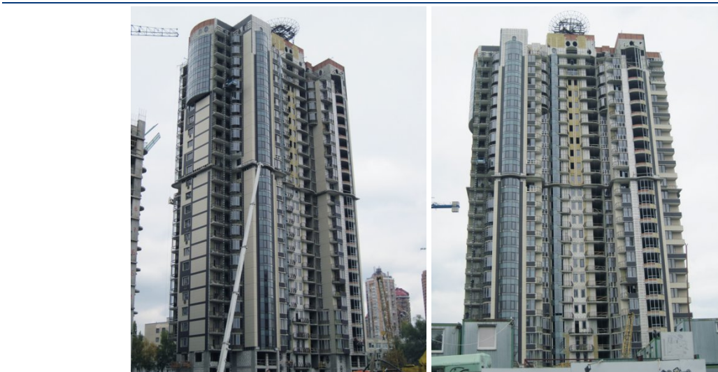
Будівництво житлово-офісного комплексу з вбудованими, прибудованими приміщеннями та підземним паркінгом по вул. Анрі Барбюса, 37/1 у Печерському районі м. Києва станом на середину жовтня 2011 року
