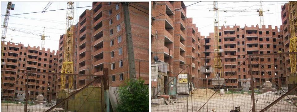
Хід робіт на об'єкті будівництва по вул. Лабораторній в с. Мізінкевичі Овідіопольського району Одеської області станом на кінець травня 2009 року
