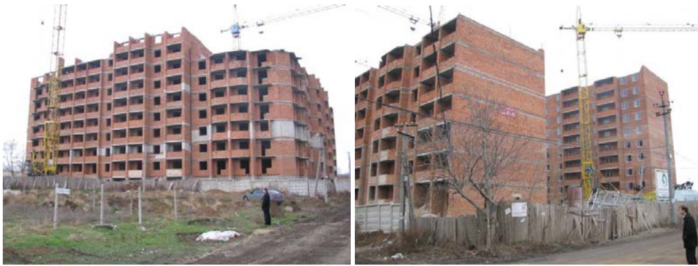
Хід робіт на об'єкті будівництва по вул. Лабораторній в с. Мізінкевичі Овідіопольського району Одеської області станом на кінець 2008 року
