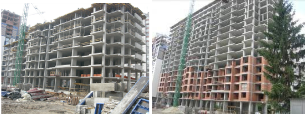
Хід робіт з будівництва ж/б 4 по вул. Професора Підвисоцького у Печерському районі м. Києва станом (зліва-направо): на 12.03.2009 р. та на 18.06.2009 р.
