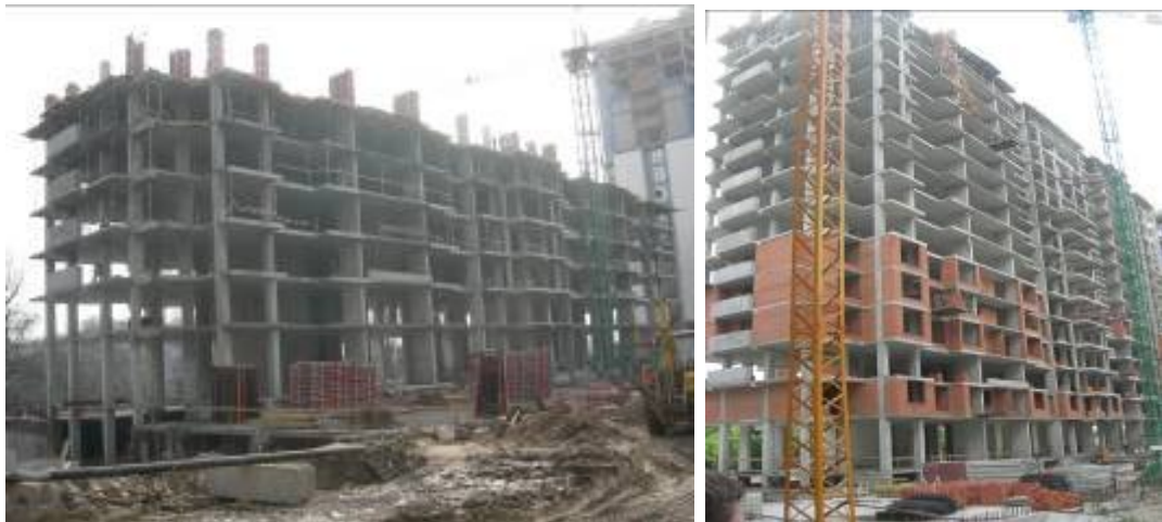
Хід робіт з будівництва ж/б 2 по вул. Професора Підвисоцького у Печерському районі м. Києва станом (зліва-направо): на 12.03.2009 р. та на 18.06.2009 р.
