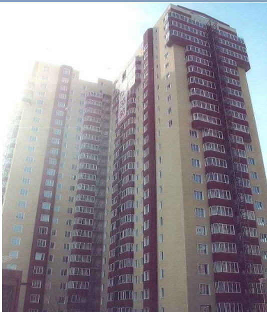
Хід робіт на об'єкті будівництва по вул. 23 Серпня (в районі буд. 31) у м. Харкові станом на кінець квітня 2010 року
