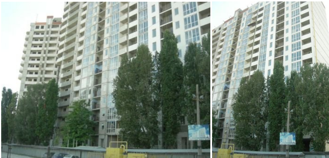
Рисунок 2. Будівництво житлового будинку по вул. Ак. Корольова, 5/2 у м. Одесі станом на 27.08.2010 року
