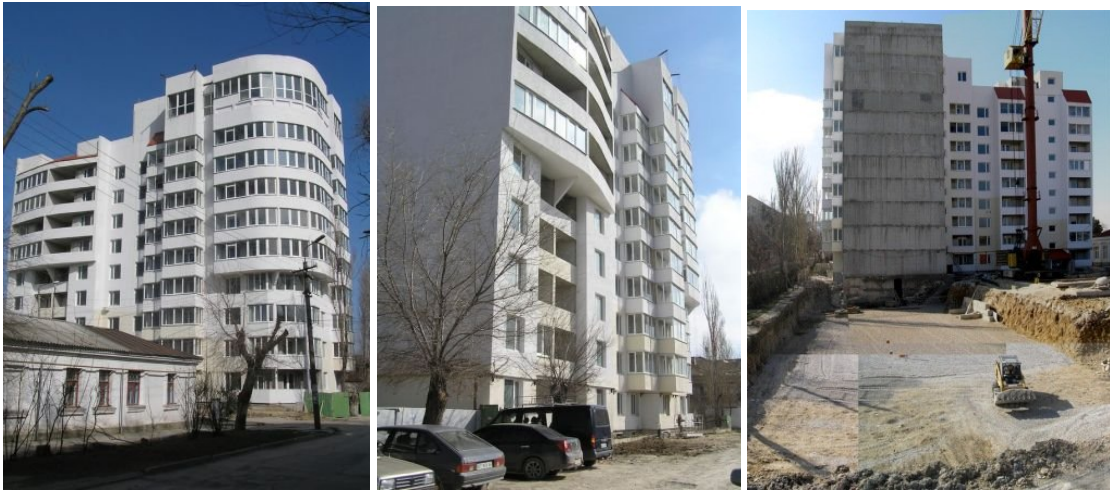
Рисунок 2. Будівельні роботи по вул. Вересаєва, 12 у м. Феодосії станом на лютий 2010 року
