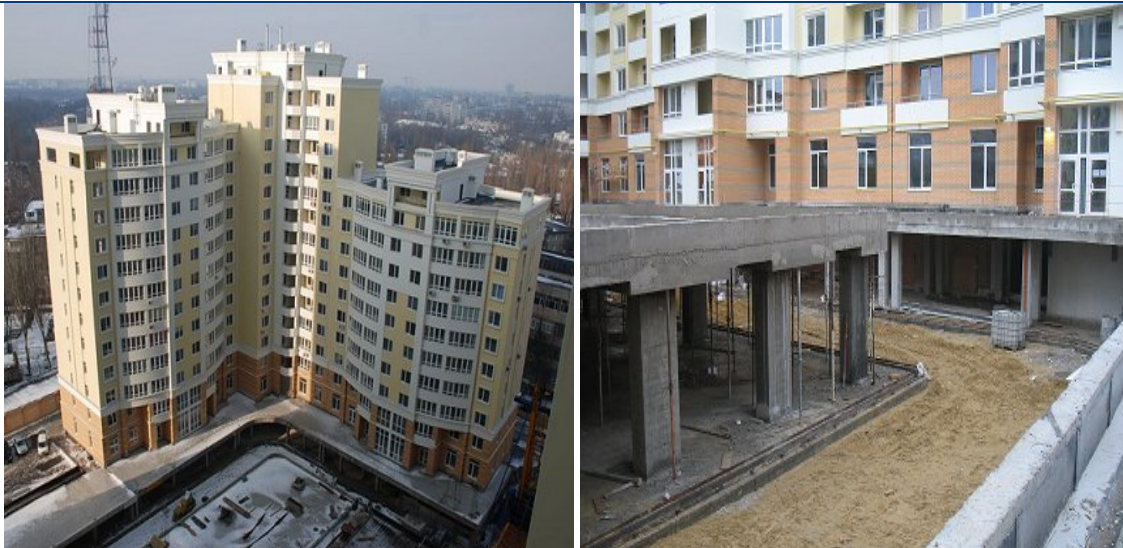
Хід будівництва житлового комплексу вул. Армійській, 11 станом на кінець січня 2011 року
