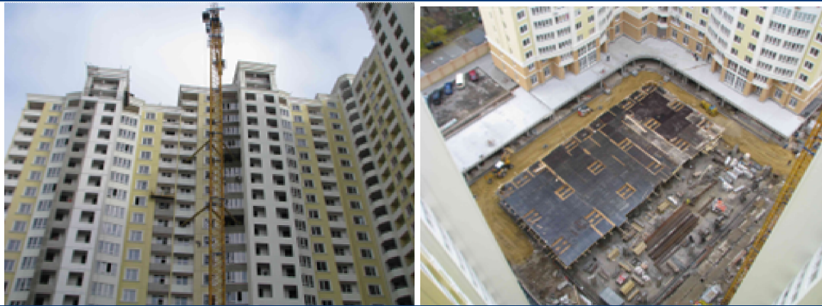
Хід будівництва житлового комплексу вул. Армійській, 11 станом на початок листопада 2010 року
