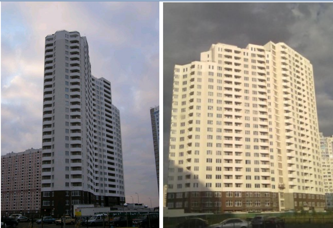
Рисунок 1. Об'єкт будівництва житлового будинку по вул. О. Пчілки у 4-му м/н ж/м Позняки
