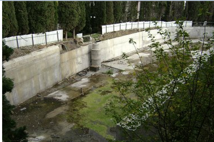
Стан будівництва за проектом реконструкції кінотеатру з добудовою рекреаційно-оздоровчого корпусу за адресою: АР Крим, смт. Гурзуф, вул. Ленінградська, 1 А станом на кінець квітня 2011 року
