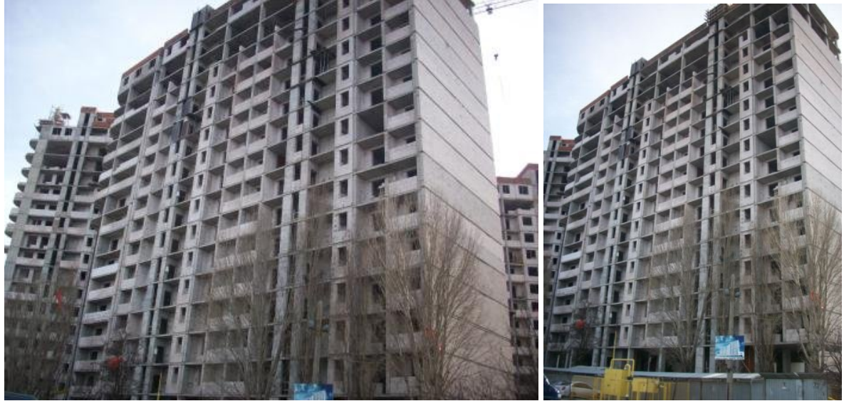
Рисунок 1. Будівництво житлового будинку по вул. Ак. Корольова, 5/2 у м. Одесі станом на 05.03.2010 року
