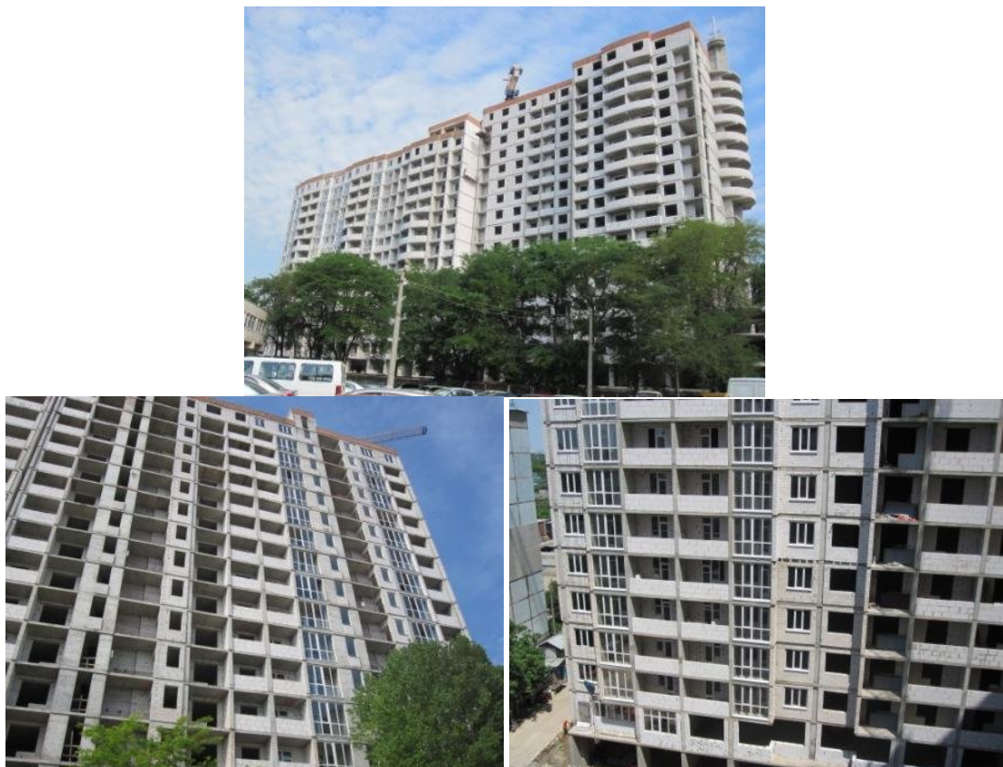
Рисунок 2. Будівництво житлового будинку по вул. Ак. Корольова, 5/2 у м. Одесі станом на 08.06.2010 року
