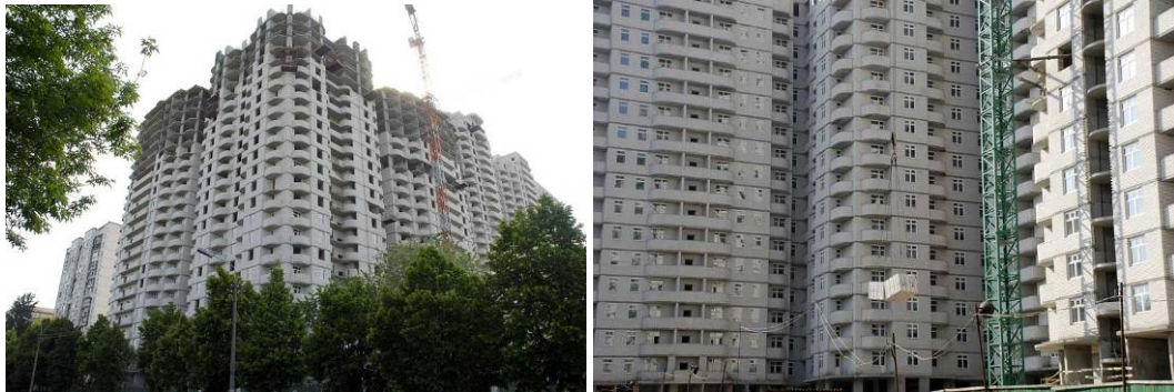
Будівельні роботи по вул. Майорова, 5А станом на середину травня 2009 року
