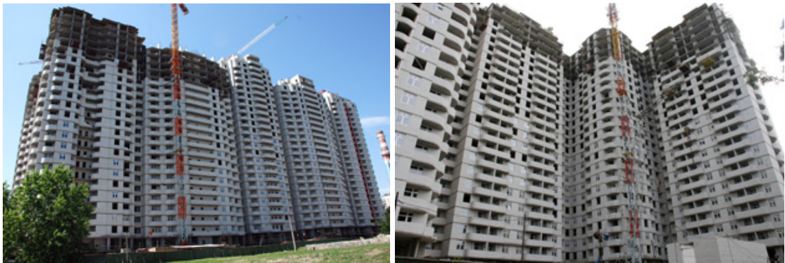
Будівельні роботи по вул. Майорова, 5А станом на середину липня 2009 року
