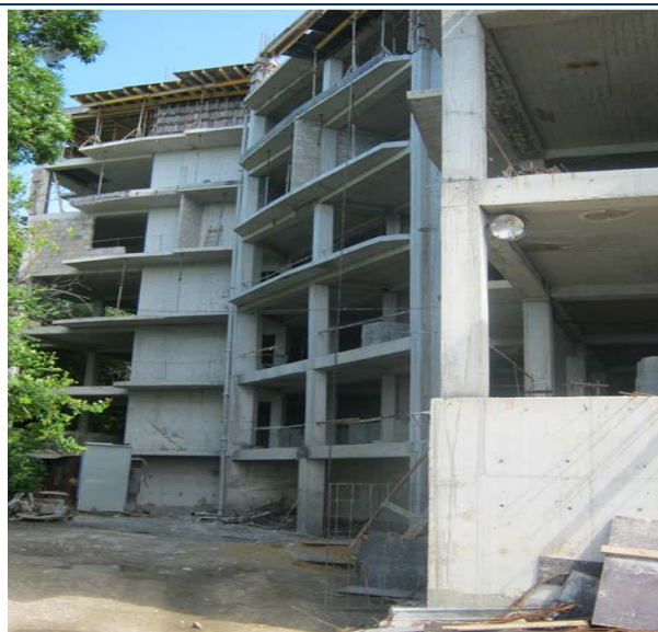
Хід будівництва рекреаційного комплексу по вул. Луговського в смт. Сімеїз станом на червень 2011 р.
