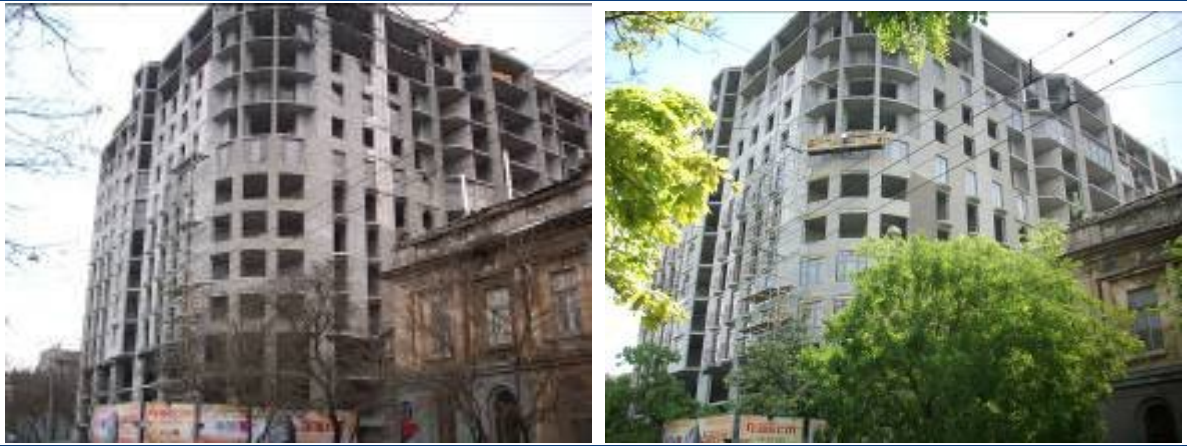
Хід будівництва житлово-торговельного комплексу по вул. Грецькій, 1 у м. Одесі станом на 20.02.2009 р. та станом на 29.05.2009 р.
