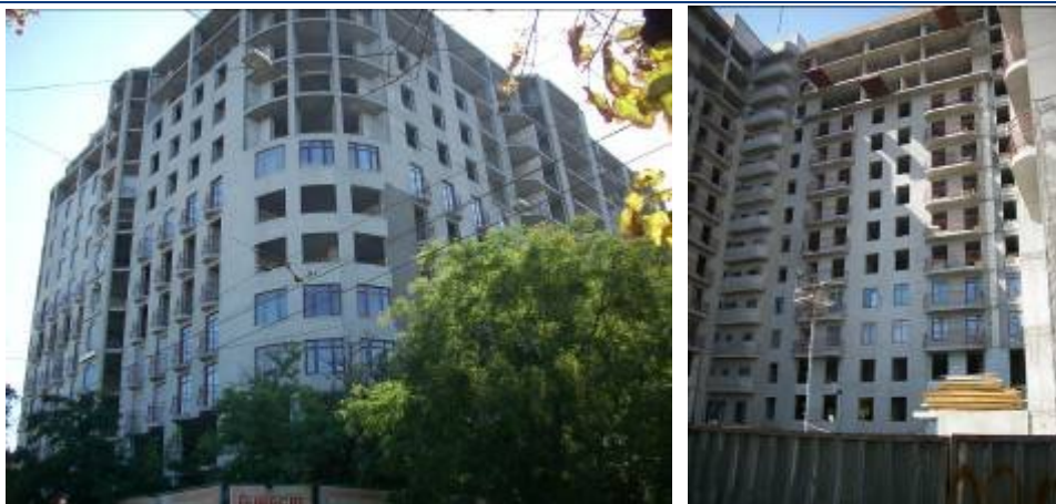
Хід будівництва житлово-торговельного комплексу по вул. Грецькій, 1 у м. Одесі станом 08.09.2009 р.
