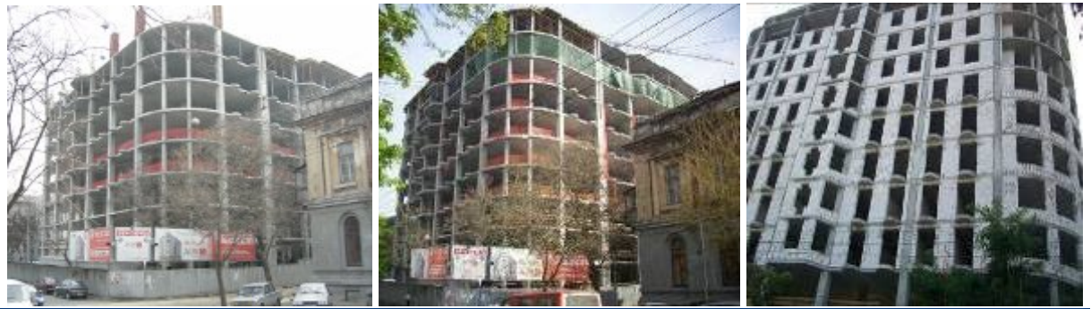
Хід будівництва житлово-торговельного комплексу по вул. Грецькій, 1 у м. Одесі станом (зліва-направо) на 01.03.2008 р., на початок травня 2008 р. та на 22.08.2008 р.
