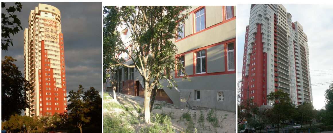
Об'єкт будівництва по вул. П. Запорозця, 26-А станом на вересень 2009 року
