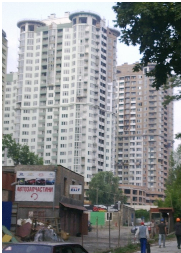
Рисунок 2. Будівельні роботи на об'єкті будівництва житлового комплексу по вул. Механізаторів, 2 (ж/к «Ізумрудний») у Солом'янському районі м. Києва станом на червень 2010 р.
