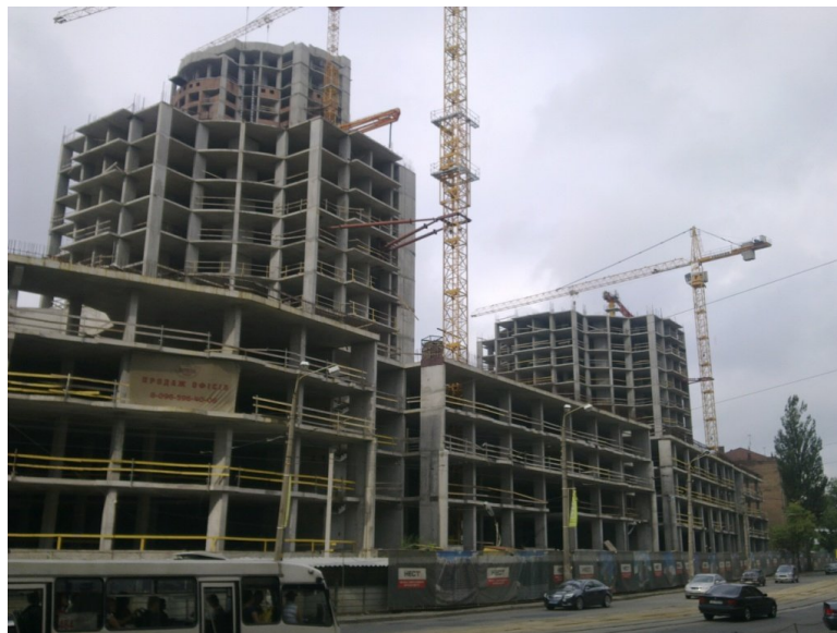
Рисунок 2. Будівельні роботи на об'єкті будівництва офісно-житлового комплексу в м. Києві на ділянці, обмеженої вулицями Глибочицькою, Студентською та Пимоненка станом на червень 2010 р.
